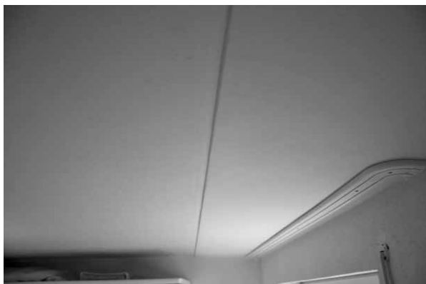
Abb. 2. Dämmkeile an der Decke zur Außenwand
