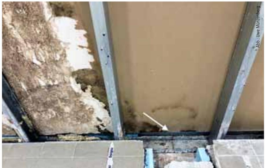
Abb. 5: Beispiel für luftundichte Montagewände: Die GK-Platten wurden nicht bis zur Bodenplatte geführt. Die gesamte Konstruktion ist daher nicht luftdicht. Sporen und andere Schimmelbestandteile können sich so je nach Druckverhältnissen im gesamten Gebäude verteilen.
