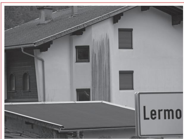
Abb. 5: Auswirkungen von unzureichendem konstruktiven Schutz
