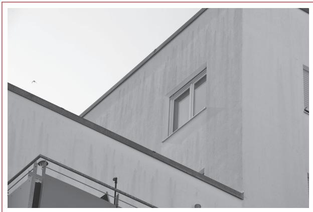
Abb. 2: Algenbefall durch unzureichenden konstruktiven Schutz
