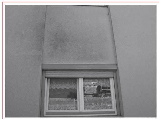
Abb. 7: Mikrobieller Befall durch nicht angepasstes Lüftungsverhalten
