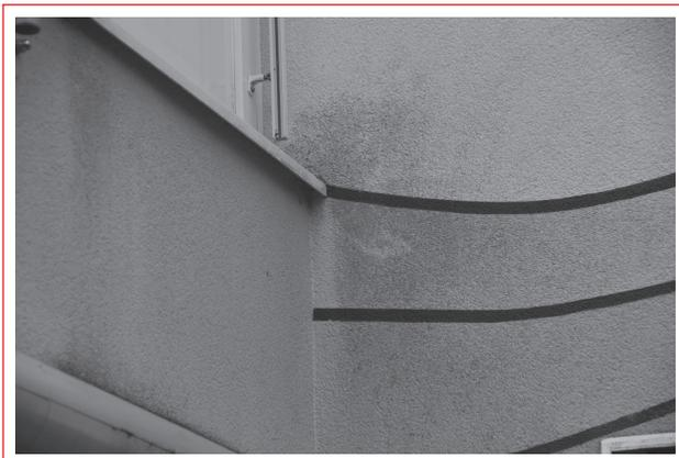
Abb. 3: Algenbefall durch erhöhte Feuchtigkeitsbelastung
