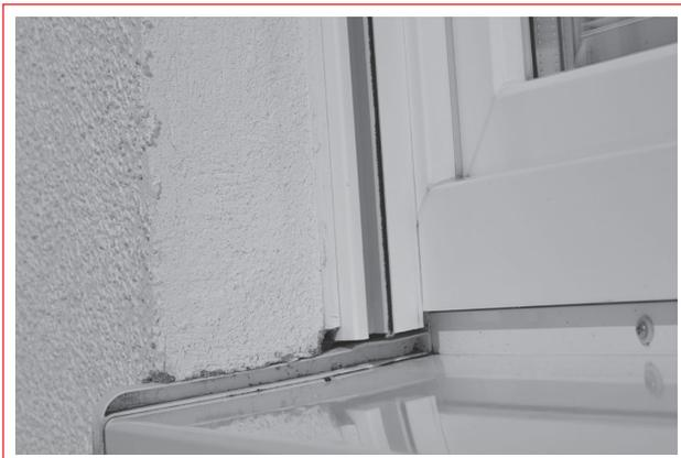
Abb. 4: Mikrobieller Befall durch nicht fachgerechte Bauteilanschlüsse
