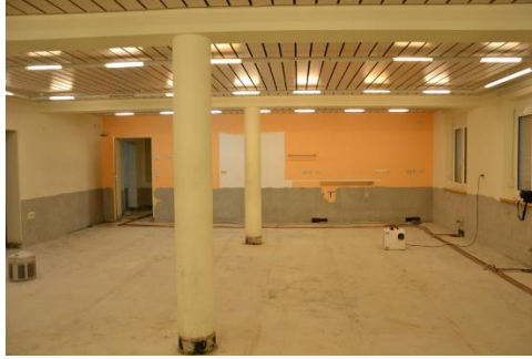
Abb. Rückbau der kontaminierten Bereiche Quelle: Robert Kussauer
