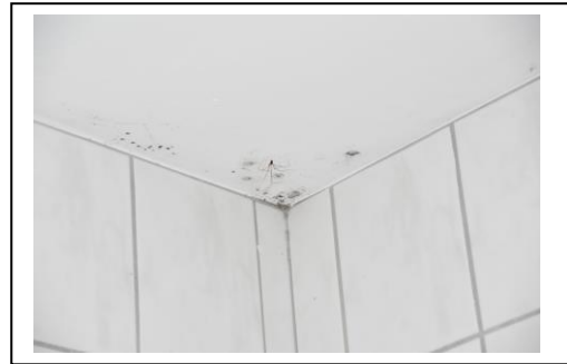
Abb. 2 Kleiner mikrobieller Schaden Quelle: Robert Kussauer
